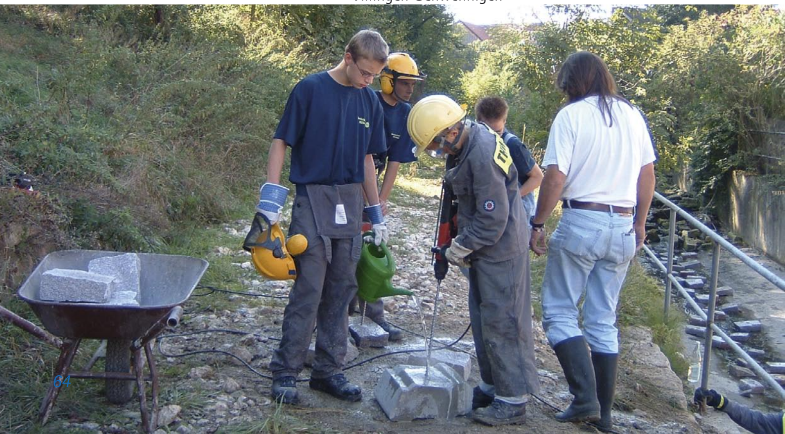
► Abb. 4.9.2 Mitglieder des Arbeitskreises „Lebendiger Neckar“ in Reutlingen beim Einbau von Störsteinen in einen Neckarzufluss. So wird dieser wieder mit dem Neckar vernetzt. Photo: BUND Regionalverband Neckar-Alb
