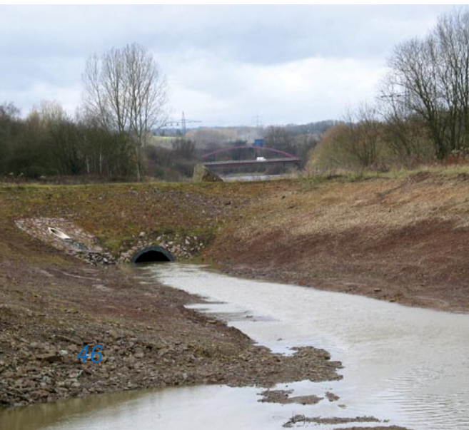
▼ Abb. 4.3.5 Rohrdurchlass zwischen den tiefer gelegten Flächen Photo: Dr. Axel Didion
