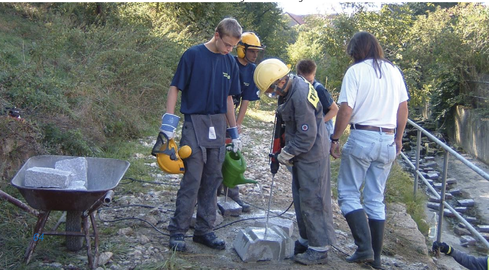
► Fig. 4.9.2 Les membres du groupe de travail « Neckar vivant » à Reutlingen lors de la mise en place de grosses pierres dans un affluent du Neckar. Ainsi celui-ci est reconnecté au Neckar. Photo: BUND Regionalverband Neckar-Alb
